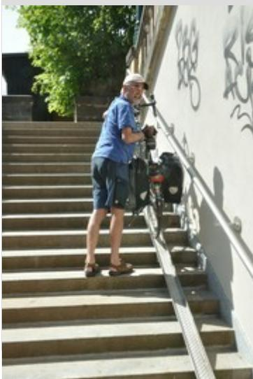
Die Schiebehilfe an der Treppe besteht aus geriffeltem Blech, der Abstand zum Handlauf ist ausreichend, um auch mit großen Packtaschen bequem schieben zu können.
